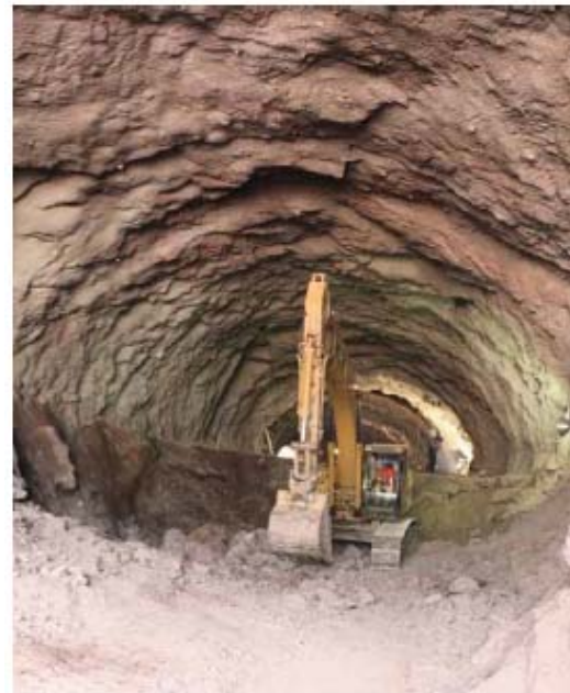
(Fig. 23) excavación de la sección inferior o banqueo
