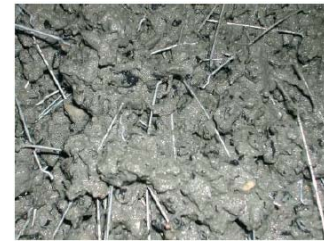
(Fig. 25) Concreto reforzado con fibras de aceros
