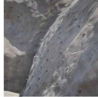
(Fig. 22) Drenes y anclas de fricción
