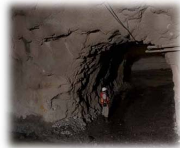
(Fig. 19) Cargador frontal realizando la rezaga de material en el interior de la galería de escape.
