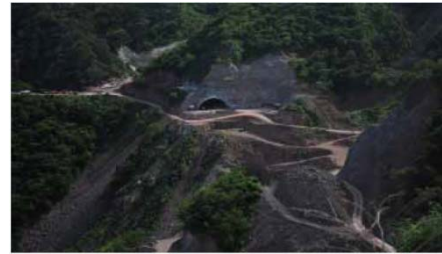
(Fig. 20) Camino de acceso
