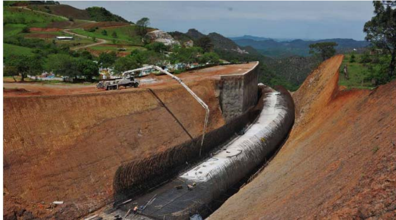
(fig. 50) Panorámica del Túnel Santa Lucía I,
