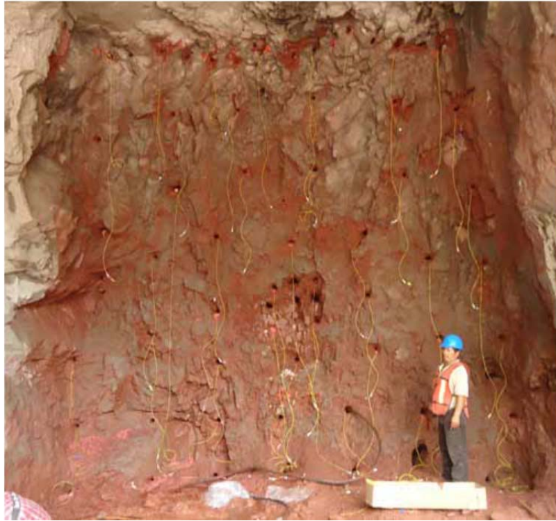
(Fig. 18) Colocación de explosivos
