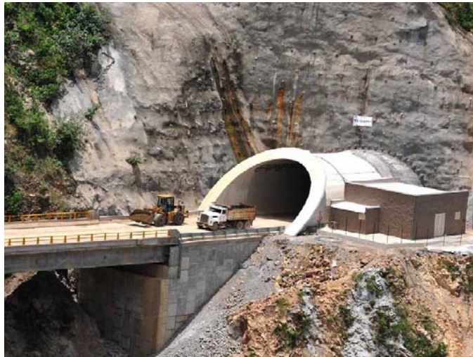
(fig. 49) Túnel del Cantil portal Durango.
